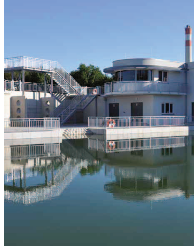
Anlage im ruhenden Betrieb
