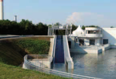
Anlage betriebsbereit für den ersten Einsatz
