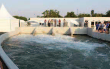
Wassereinflaß – 3 Pumpen leiern 12m³ in der Sekunde
